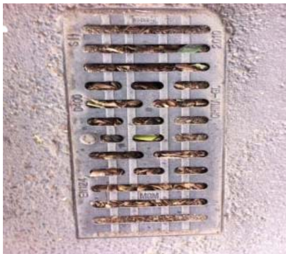
קולטן סתום עד פני הקרקע בפינת הרחובות שד' ירושלים ורחוב עולי ציון כפי שתועד על ידי הביקורת בתחילת חודש ינואר 2017.
