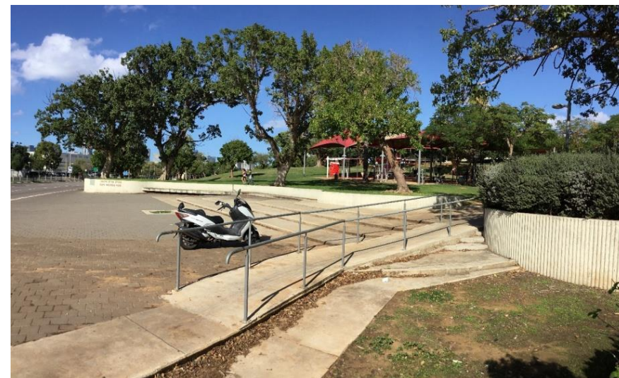
הנגשת רחבת הכניסה לפארק מכיוון מכללת אורט סינגאלובסקי. רמפת בטון וריצוף הרחבה בלבנים אדומות. 2021.
