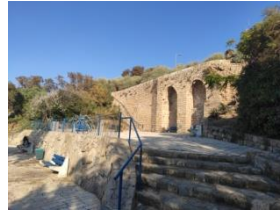
2. חלק ממבנה קשתות ששולב בגן בקיר תמך ודופן לרחבה
