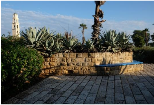
קירות תמך נמוכים כפתרון למיתון הפרשי מפלים, משולבים באלמנטים של הגן כגון ערוגות, קירי ישיבה, מעקות ועוד. 2021.
